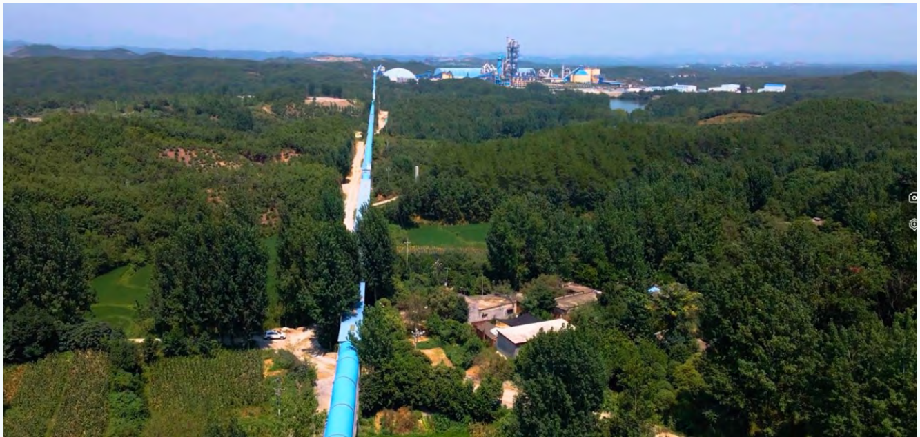
礦山 - 工廠皮帶廊傳輸設施
