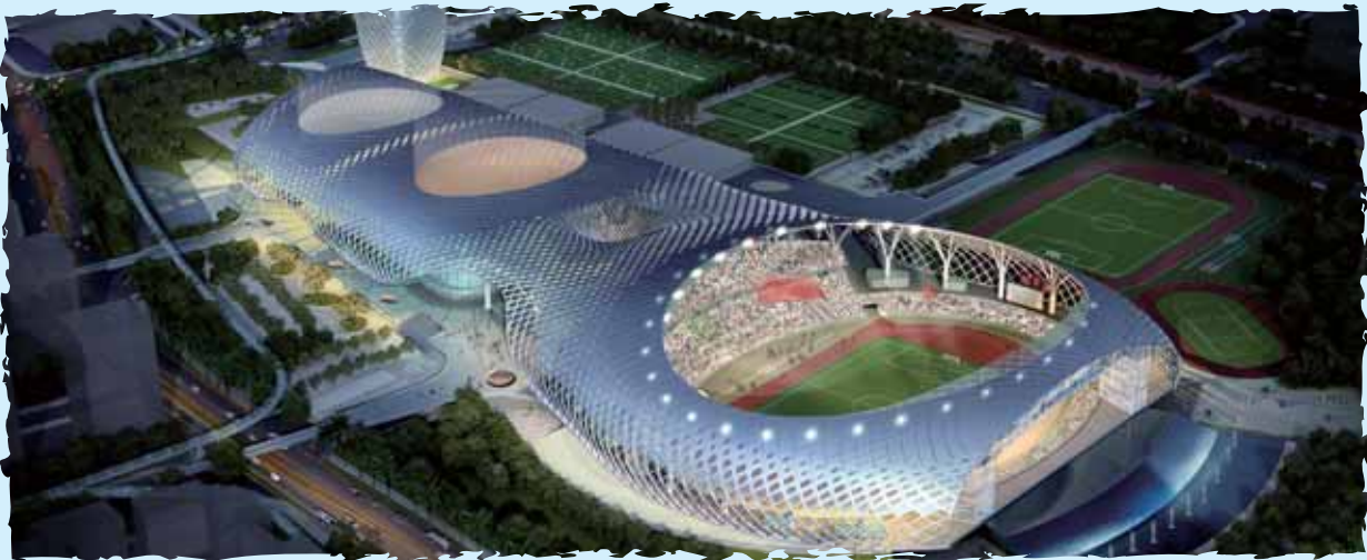
深圳灣體育中心工程項目
