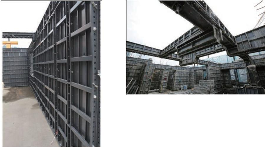
除模板服務外，我們亦提供腳手架(一種臨時結構，用於支撐工人及材料，以進行樓宇建造、維護及維修工程)組裝服務。金屬腳手架通常用於本集團的模板設計及安裝。我們的腳手架服務為建築商及建築承包商提供高空作業的通道解決方案。於往績記錄期間，我們的腳手架結構主要包括(i)扣件式鋼管腳手架；及(ii)附著式升降腳手架。由於我們的研發能力，我們設計智能導架式升降平台及全型鋼附著式升降腳手架以逐步替代扣件式鋼管腳手架及附著式升降腳手架。詳情請參閱下文「研發」。
