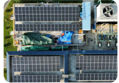
臨沭危廢焚燒項目利用廠區內現有建築物屋頂，分別在公用工程樓、綜合泵房、機修間、化驗室等屋頂建設光伏發電項目，安裝面積約 2,000 平方米，裝機容量 0.4 兆瓦。
