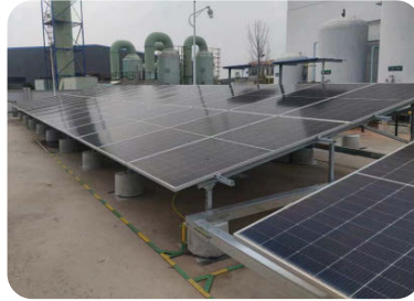
新沂固廢處置項目利用填埋場建築物屋頂及水池池面建設光伏電站，合計安裝面積約 2,162 平方米，總安裝容量約為 0.2 兆瓦；新沂危廢處置項目利用廠區建築物屋頂及水池池面建設光伏電站，合計安裝面積約 9,218 平方米，總安裝容量約為 0.91 兆瓦。
