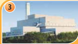
3 科維垃圾焚燒發電廠 (營運中)
