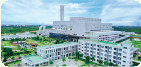
電白垃圾焚燒發電項目
