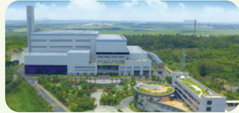
湛江垃圾焚燒發電項目
