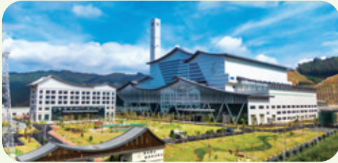
清遠垃圾焚燒發電項目
