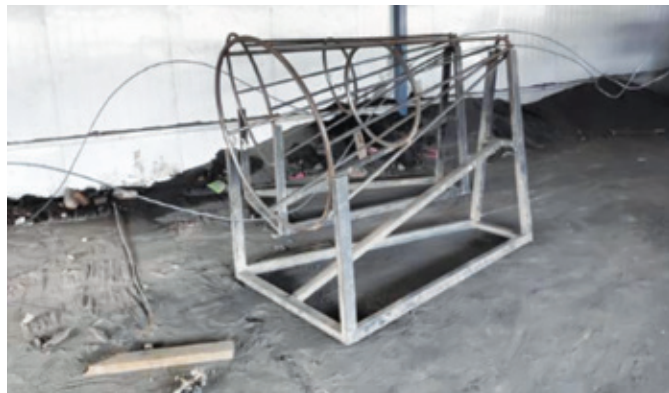
鋼筋調直防護
