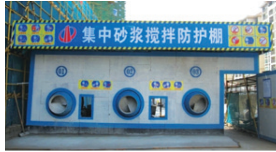
設置防雨、防砸棚
