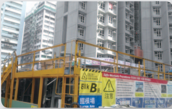
鐵模、預製件存放區
