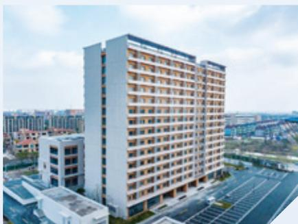
二月五日，由集團旗下中建國際投資、中海建築有限公司(以下簡稱「中海建築」、中建海龍科技有限公司(以下簡稱「中建海龍」)設計建造的浙江嘉興百步經濟開發區工業社區鄰里中心項目一期順利竣工驗收，該項目為的全國首個裝配整體式剪力牆結構混凝土模塊化集成建築。
