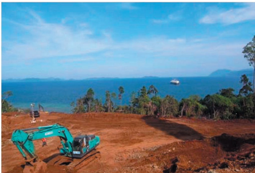
图 11-2: 临时码头所在地
