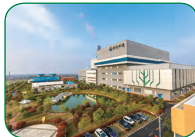
南昌泉嶺發電廠
